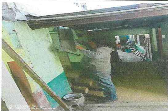
Foto 3: Reparación de canales.
