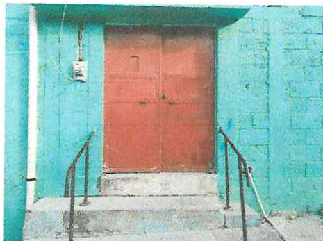
Foto 5: Pintura y reparación para puertas y barandas.
