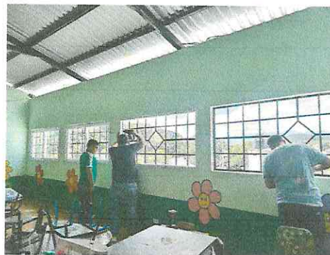
Foto 2: Ventanas de pvc para salón de clases 2
